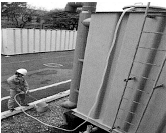
③ サイホン利用しマンホールから給水
